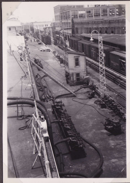
Polttoöljyn lastaus käy nopeasti pumppaamalla 8.7.47
